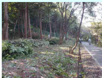
緩衝帯の整備
